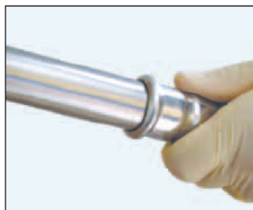
Introducir el accesorio en el tubo girando y empujando
